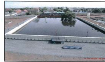
รูปที่ 6 : การทดสอบกำแพงป้องกันน้ำท่วม
